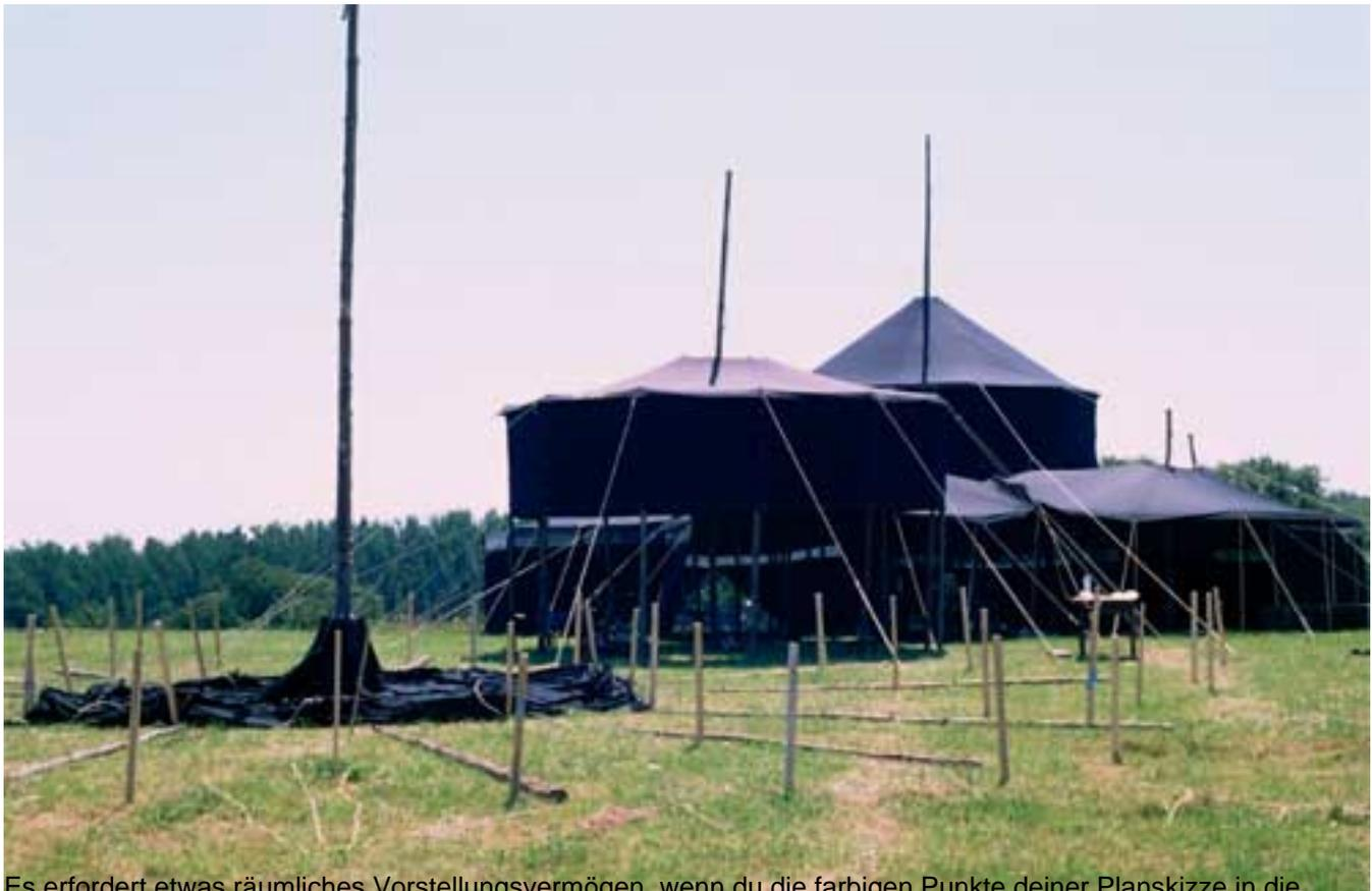
Es erfordert etwas räumliches Vorstellungsvermögen, wenn du die farbigen Punkte deiner Planskizze in die Realität übertragen willst. In detaillierter Kleinarbeit kannst du mit einem langen Maßband entsprechende Hilfsdreiecke aufspannen, welche dich zu jedem Punkt (Stange oder Hering) deiner zukünftigen Jurtenburg führt.
